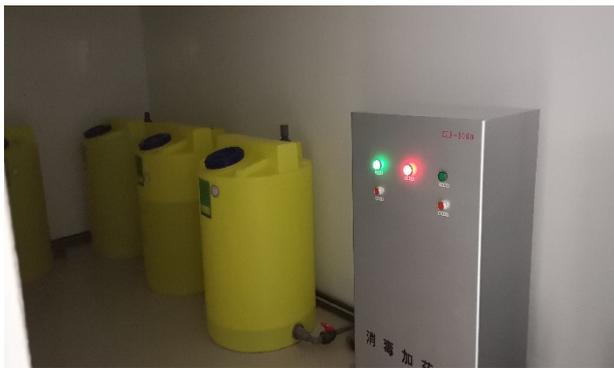
图 4-2 储药罐、加药装置
