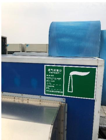
图 4-11 油烟废气排气口
