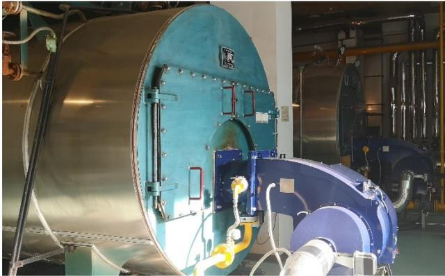
图 4-9 锅炉低氮燃烧器
